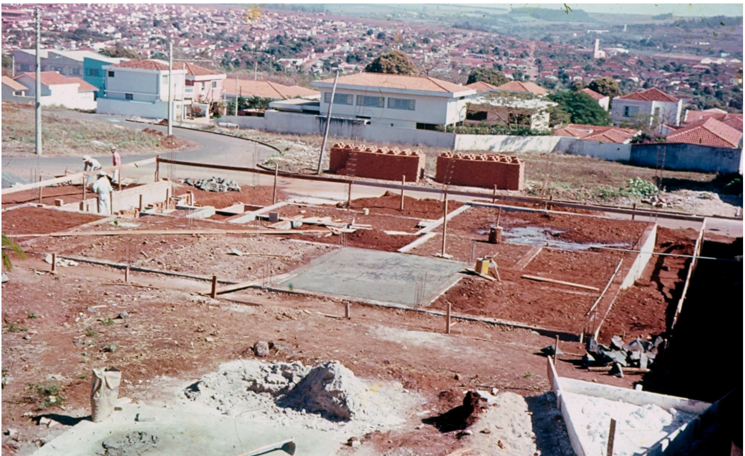
Figura 01: construção da Residência Clotilde e Sérgio Ferreira. Fonte: Acervo do arquiteto João Batista Martinez Corrêa (1968/1969 apud FERREIRA e PERES, 2022).
