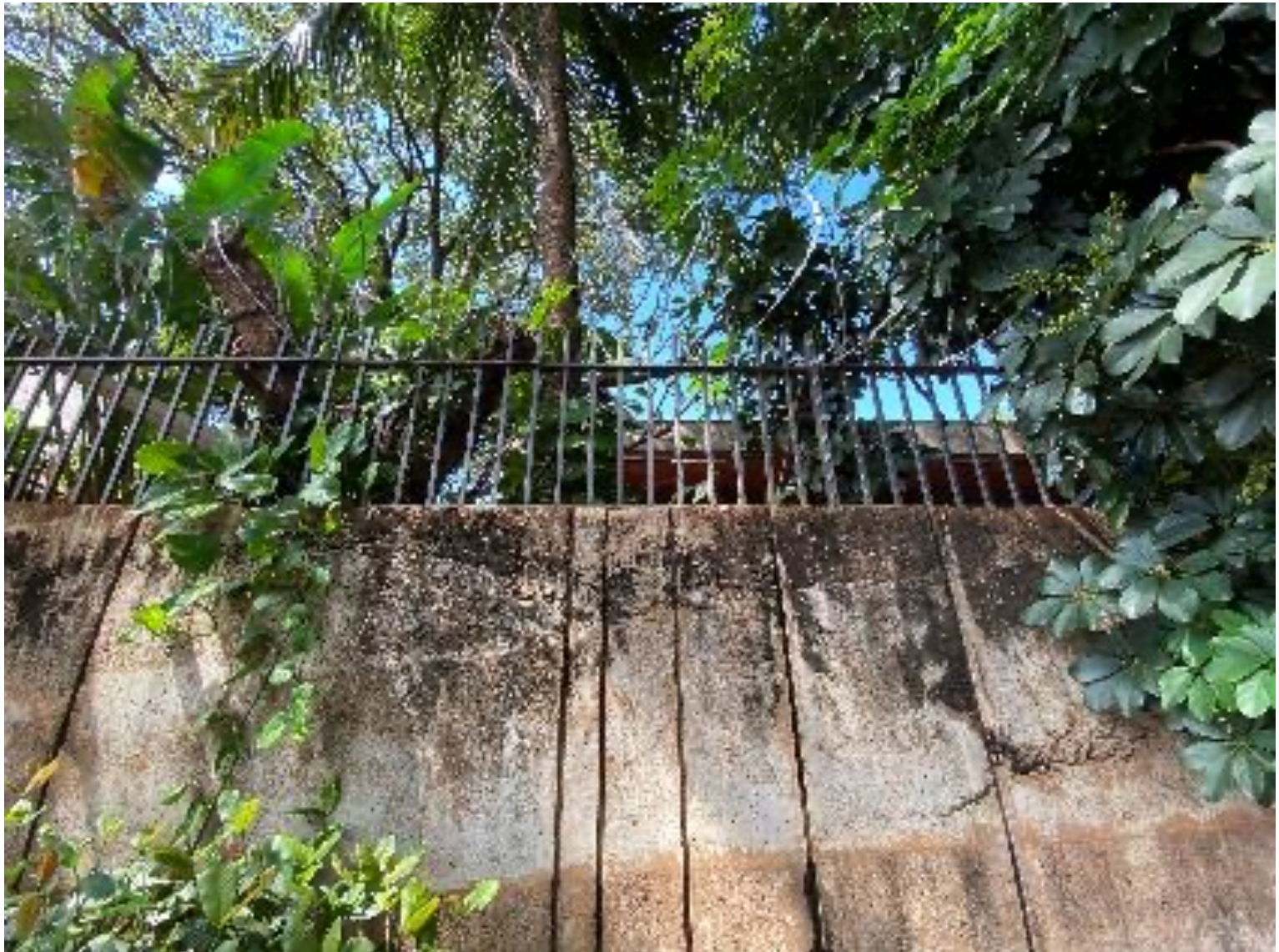
Figura 15: Residência Clotilde e Sérgio Ferreira, vista do muro de arrimo em concreto aparente, com marcas das fôrmas, mostrando o padrão Fibonacci. Fonte: FERREIRA e PERES, 2022.
