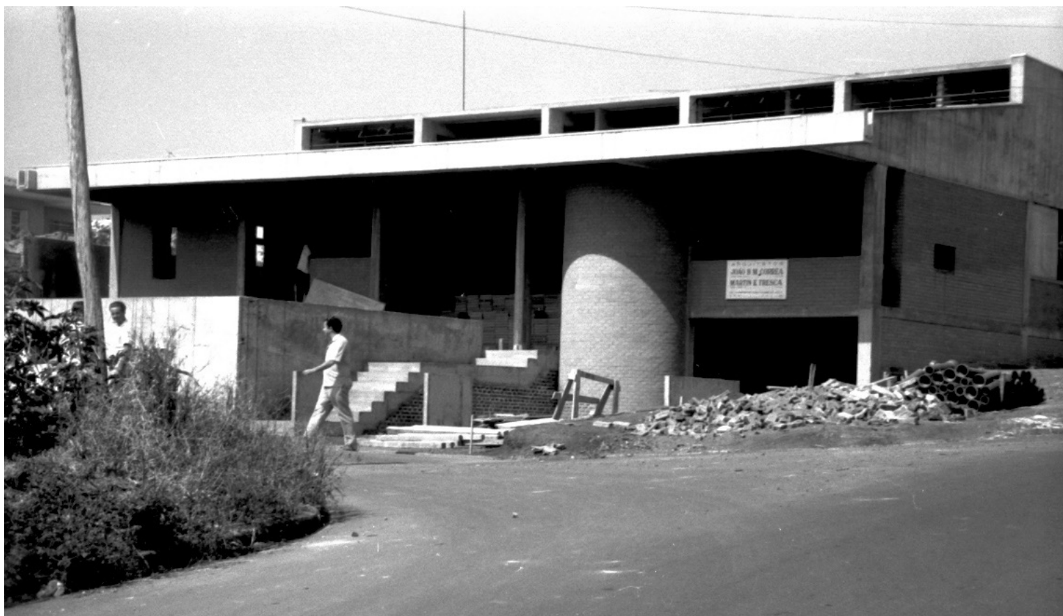
Figura 02: construção da Residência Clotilde e Sérgio Ferreira. Fonte: Acervo do arquiteto João Batista Martinez Corrêa (1968/1969 apud FERREIRA e PERES, 2022).
