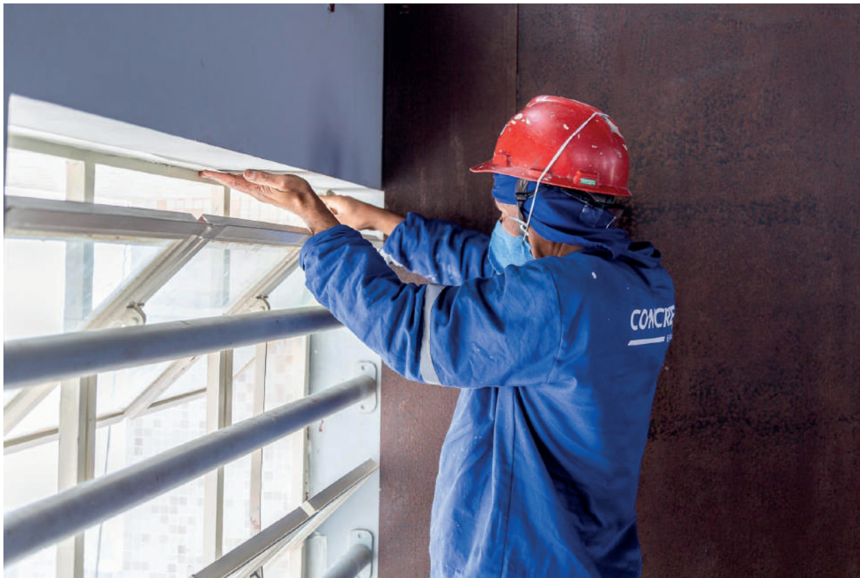
Restauro da fachada do Farol Santander - Edifício Altino Arantes em São Paulo, SP. Crédito da foto: Léo Giantomasi (fotógrafo de arquitetura)/ Acervo do autor.
